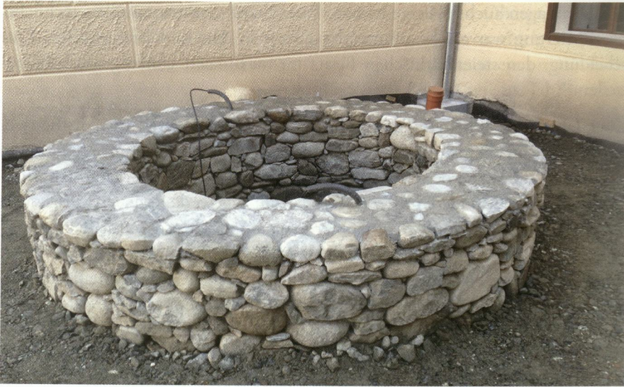
Abb. 85: Der freigelegte mittelalterliche Brunnen im Innenhof des Schlosses Wasserberg, 2014 (Foto: Stiftsbauamt Heiligenkreuz).
